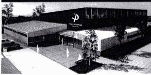
CONSTRUCCIÓN PRIMER POLIDEPORTIVO COMUNA DE CALBUCO.
